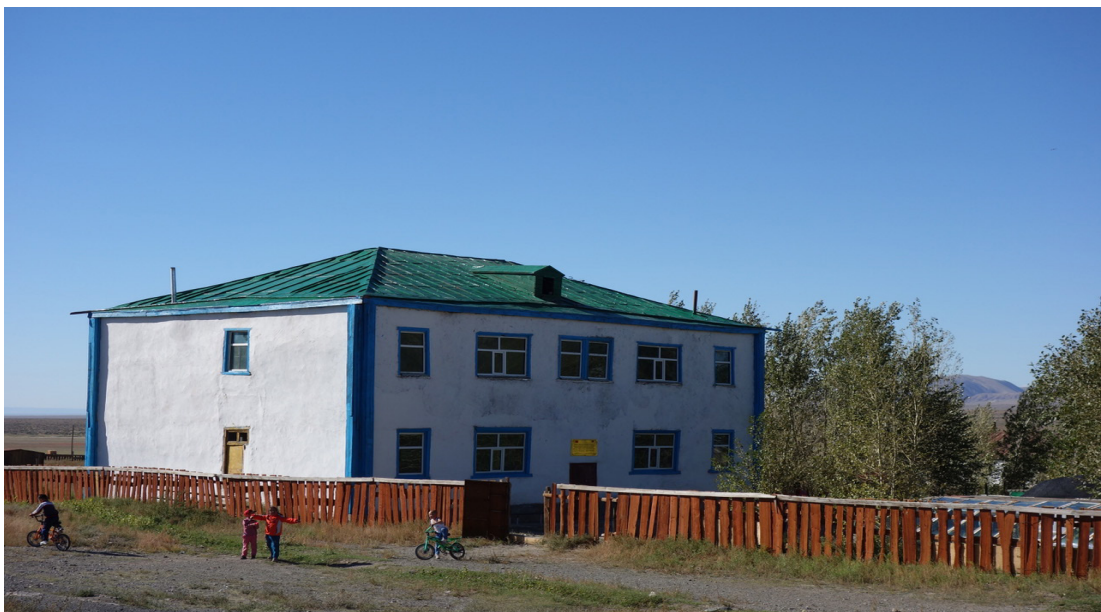
Abb. 2: Lehrwerkstättengebäude. Foto: S. May
